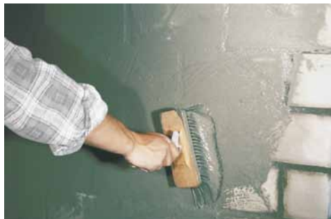
CR 90 Crystaliser uzklāšana ar otu
