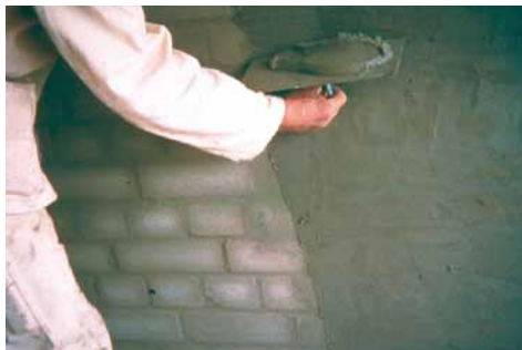
CR 90 Crystaliser uzklāšana ar rīvdēli
