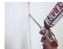
Spraugu aizpildīšana starp plāksnēm
