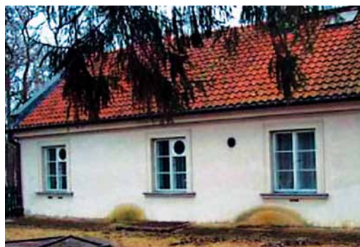
Cokola samirkšana, kuras cēlonis ir nenoblīvētas notekcauruļu savienojuma vietas.
