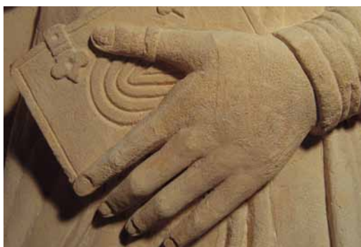
Magdalēnas Kočmerovskas (Magdalena Koczmerowska) kapakmens statujas delna, kas restaurēta, izmantojot javu Ceresit CR 41 un CR 44 (V.J.M. Piedzimšanas draudzes baznīcas Čhovā).
