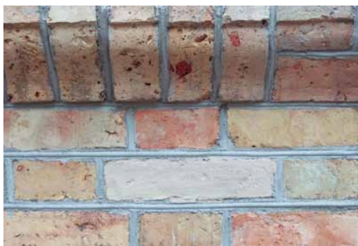
Pirms galveno darbu uzsākšanas eksperimentālā ceļā objektā jāpiemeklē piemērots javas krāsas tonis, pievienojot tai pulverveida pigmentu.
