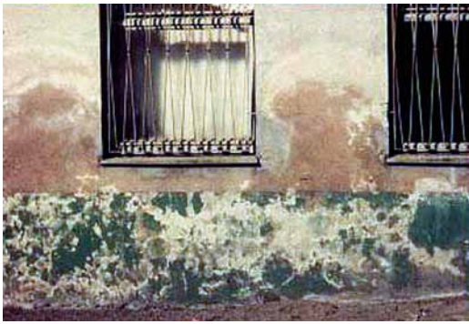
Ārmetuma degradācija sāļu kristalizācijas rezultātā.
