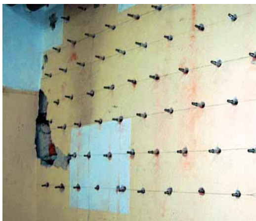
Strukturālā spiediena injekcija ar preparātu Ceresit CO 81. Tā kā nav iespēju izveidot izolāciju no ārpuses, tā tiek veidota sienas joslā.
