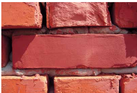
Pirms galveno darbu uzsākšanas eksperimentālā ceļā objektā jāpiemeklē piemērots javas krāsas tonis, pievienojot tai pulverveida pigmentu.
