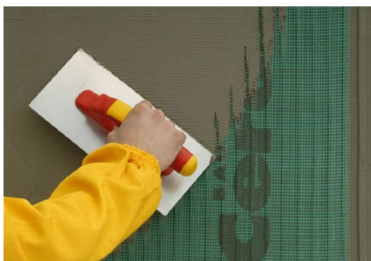
Sieta iestrāde armēšanas javā, kas uzklāta siltinājuma loksnes
