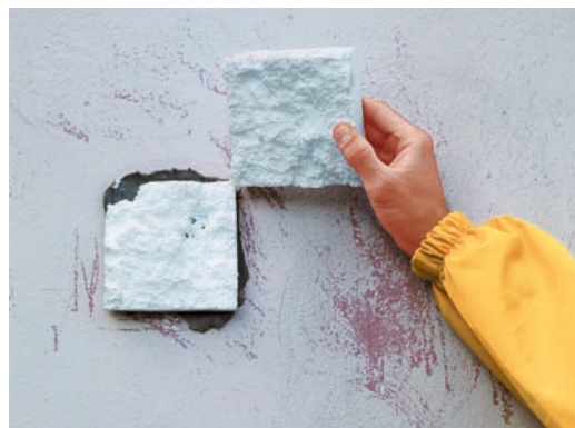
Otra pārbaudes metode jeb pull-off tests
