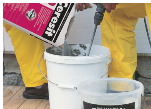
Maisīšanai spainī vispirms ielej ūdeni un pēc tam ieber maisījumu
