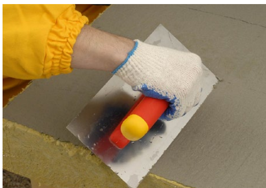
Minerālvates loksnes vienmēr rekomendējoši jānogruntē ar plānu līmjavas kārtu
