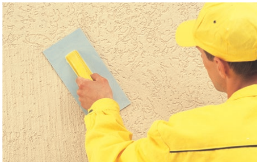
Ar mizgrauža struktūru var izveidot dažādus rakstus
