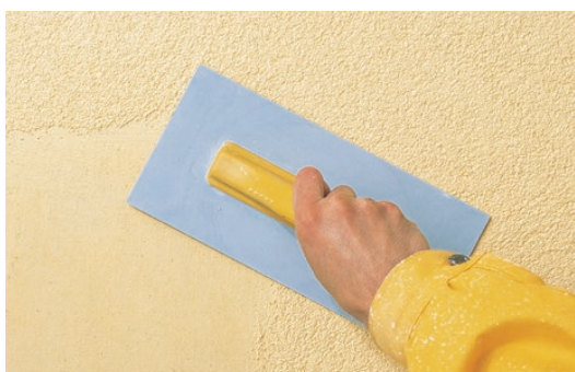
Apmetumi ar akmens struktūru piešķir virsmai blīvi graudainu izskatu
