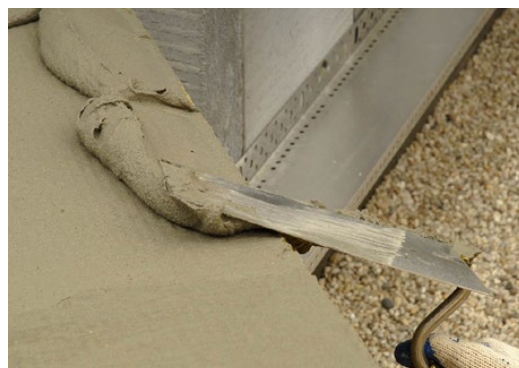
Siltināšanas loksnes malās uzklātajam maisījumam ir jāpārklāj viss plāksnes perimetrs
