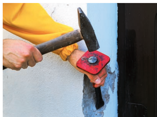
Vajējs apmetums un citas pamatnes daļas, kas atdalās, ir mehāniski jānoņem
